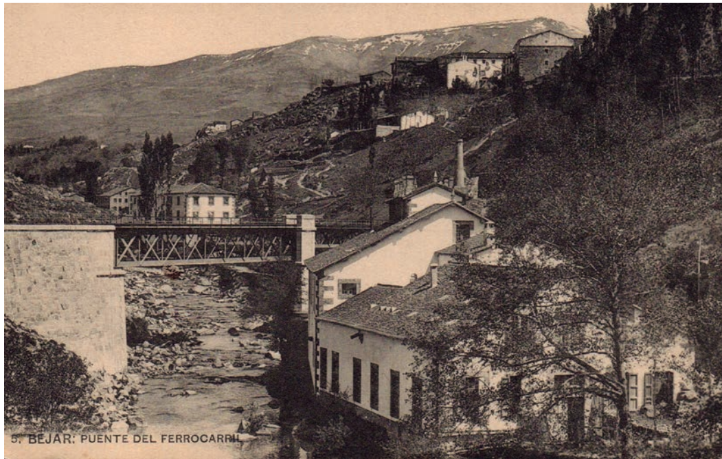
Ilustración 2. Puente del ferrocarril y la antigua factoría de Tinte de Gilart
